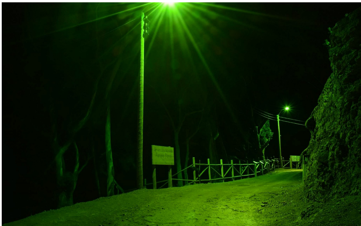
Figura 6. Luminarias de bajo impacto para las aves marinas instaladas por Oikonos y la Municipalidad de Juan Fernández en el único sitio de nidificación de Ardenia creatopus en el poblado de San Juan Bautista.
